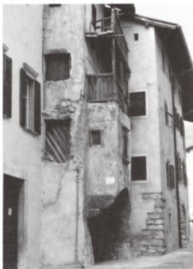
Fig. 17 finestra a sporto a Vezzano
