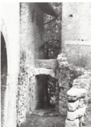
Fig. 20 archi di sostegno tra case a Calavino
