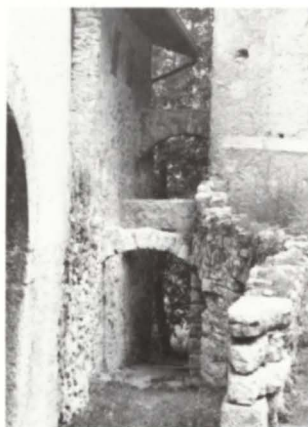
Fig. 20 archi di sostegno tra case a Calavino
