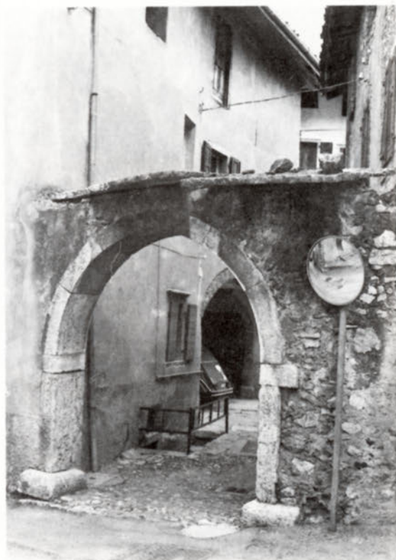
Fig. 6 - Portale d'accesso al cortile e all'aia aperta
