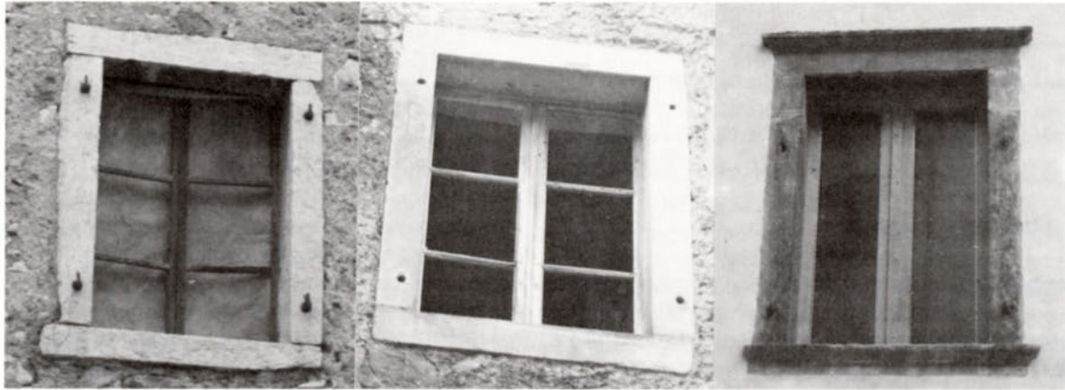
Fig. 9 a) pilastràde de préda b) pilastràde a malta fina c) con davanzale e architrave lavorati
