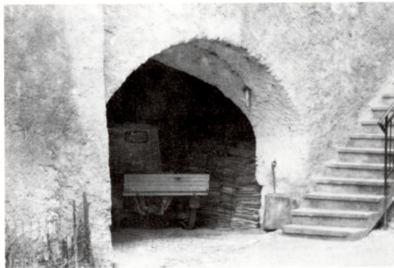
Fig. 5 - Aia coperta con accesso aperto
