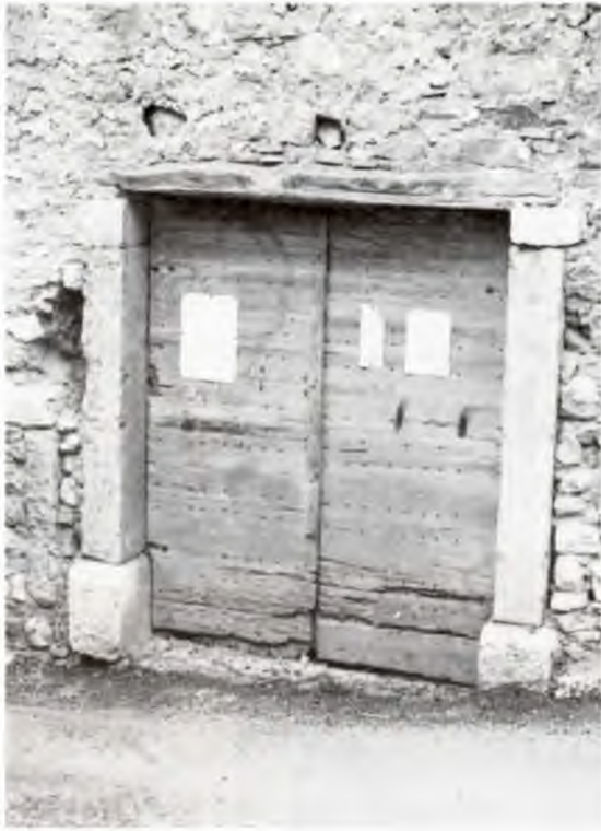
Fig. 8 a) portale rettangolare con architrave in legno
