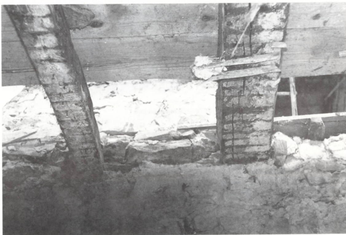
Foto 3: Le "piane" con residui di "filéti" e pavimento
