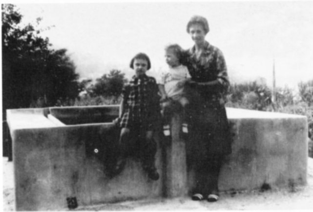
Lavatoio in cemento - n. 5
