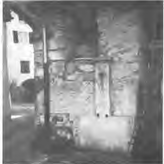
Qui c'è resto di una delle fontane demolite
